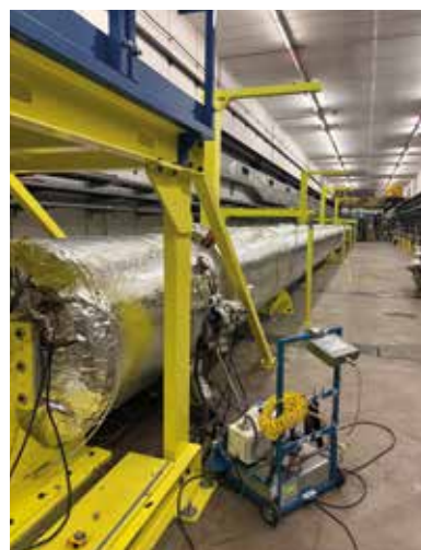
Figuur 3. De 36 meter lange pilotsector met alle pompen, instrumentatie en isolatie geïnstalleerd.
